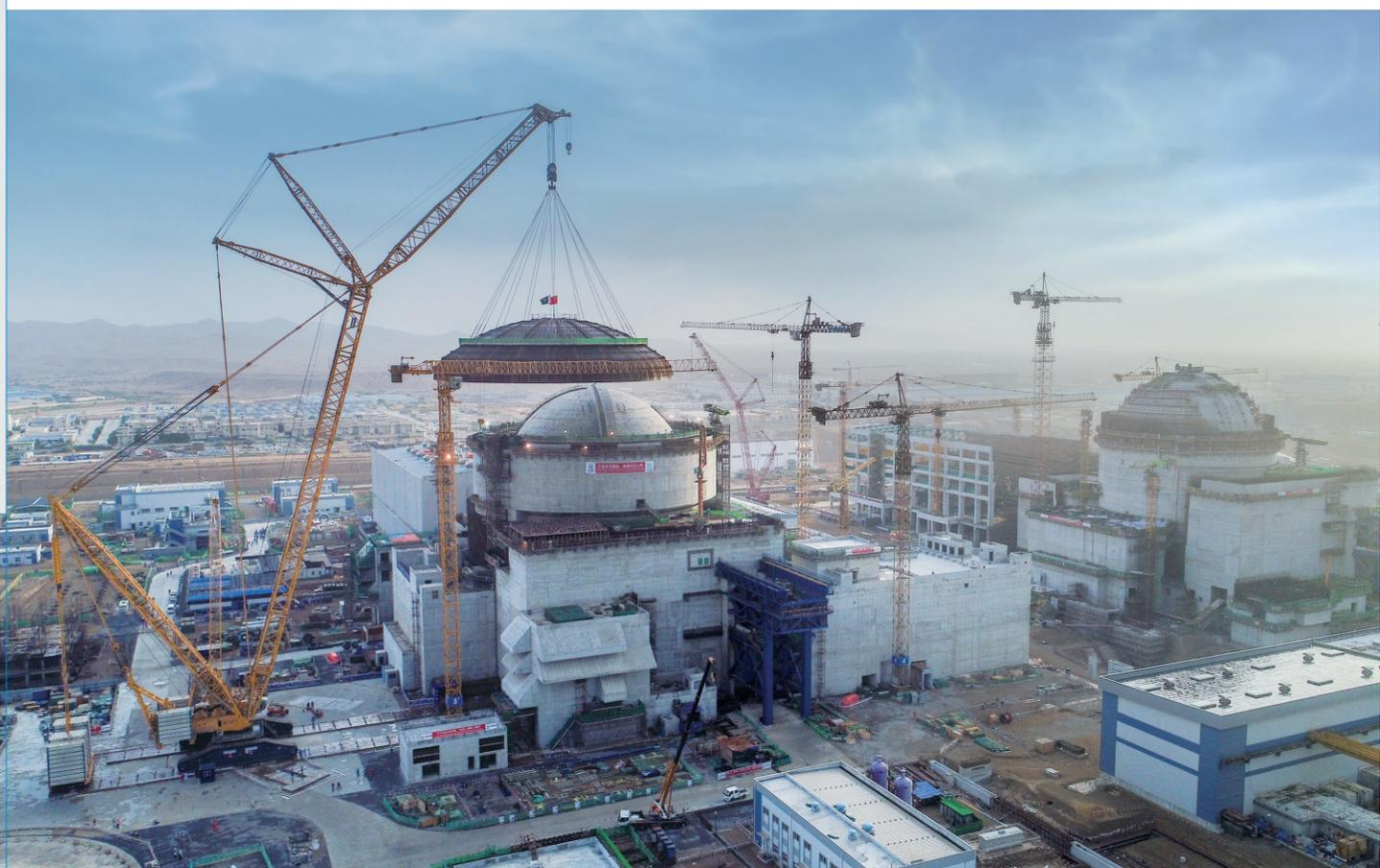
2019 年 6 月 17 日，K2 核岛外层安全壳穹顶成功吊装，为后续安全壳整体试验和热试创造了有利条件
