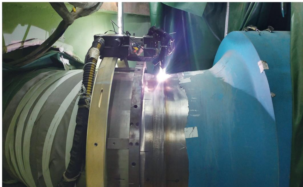
田湾核电 6 号机组主管道冷热段自动焊焊接
